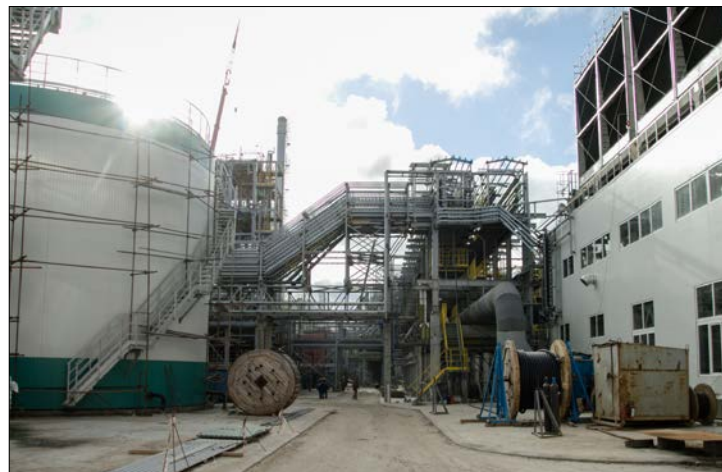
Работы на новом комплексе по производству аммиака и метанола близятся к завершению.
