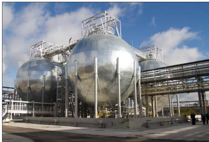
Хранилище аммиака – часть комплексной установки.
