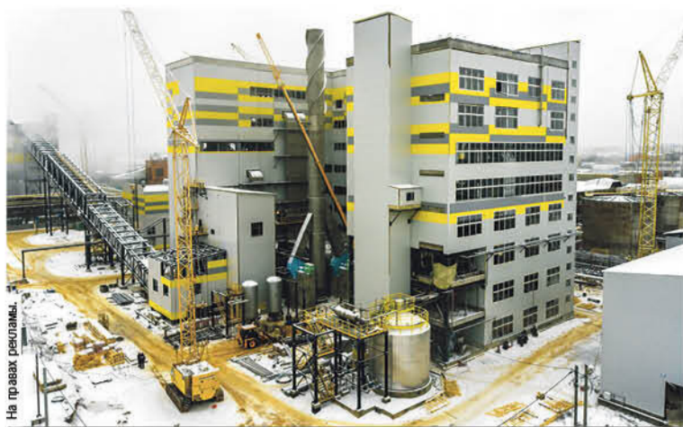
На правах рекламы. Комплекс АК/АС готовится к началу пусконаладочных работ.
