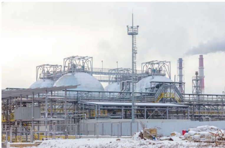
Новая установка по выпуску метанола и аммиака будет уникальной
