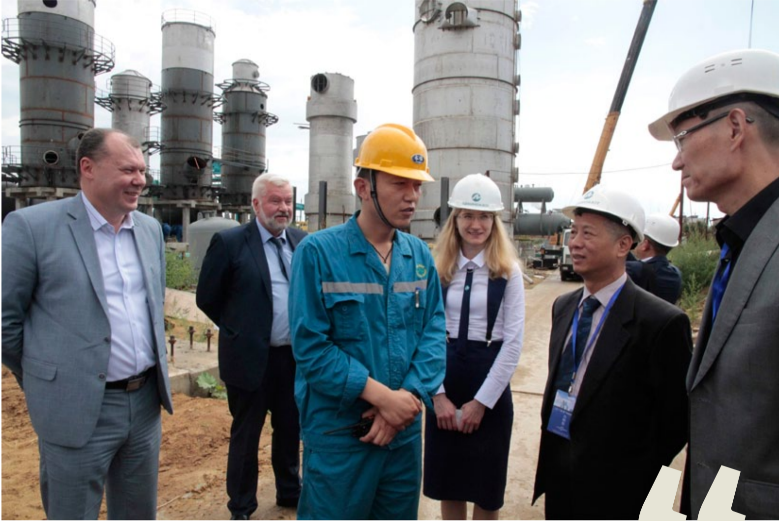
Монтаж производства серной кислоты ведет китайская фирма
