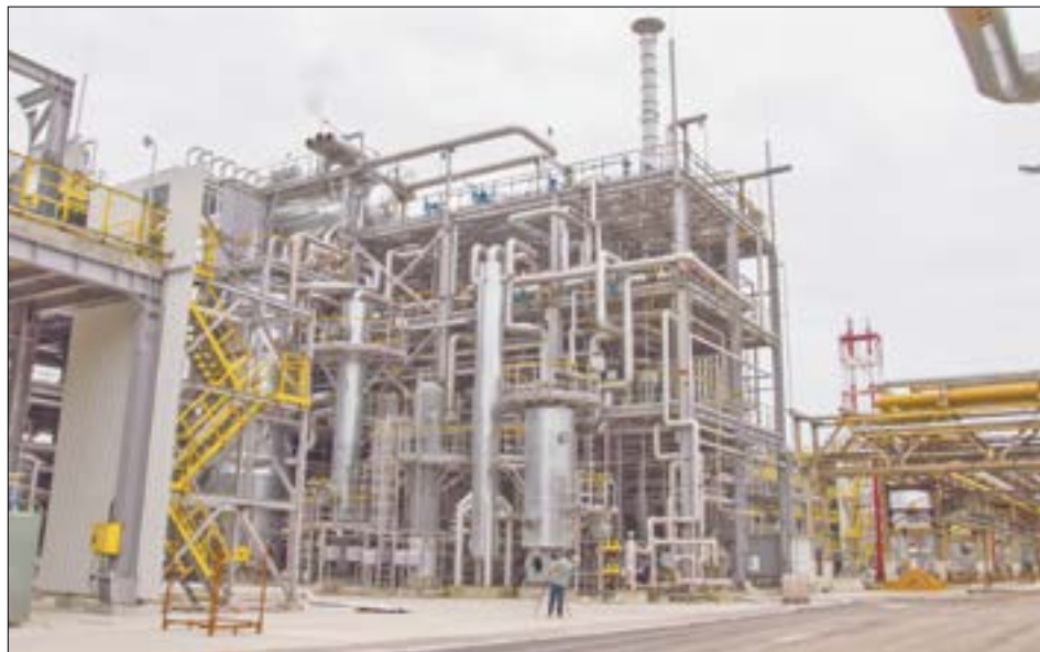
Строительно-монтажные работы на установке М-450/А-135 завершены.
